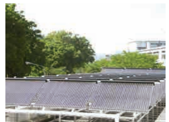
日光霧降アイスアリーナ様（栃木県） 用途：スケートリンクの製氷に使う温水 設置枚数：32 セット
