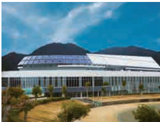
ならはスカイアリーナ様（福島県） 用途：温水プールの昇温、給湯 設置枚数：58 セット
