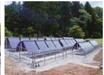
日光霧降アイスアリーナ様（栃木県） 用途：スケートリンクの製氷に使う温水 設置枚数：32 セット
