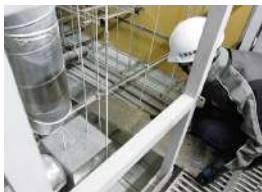
天井裏の構造を模した設備も完備
